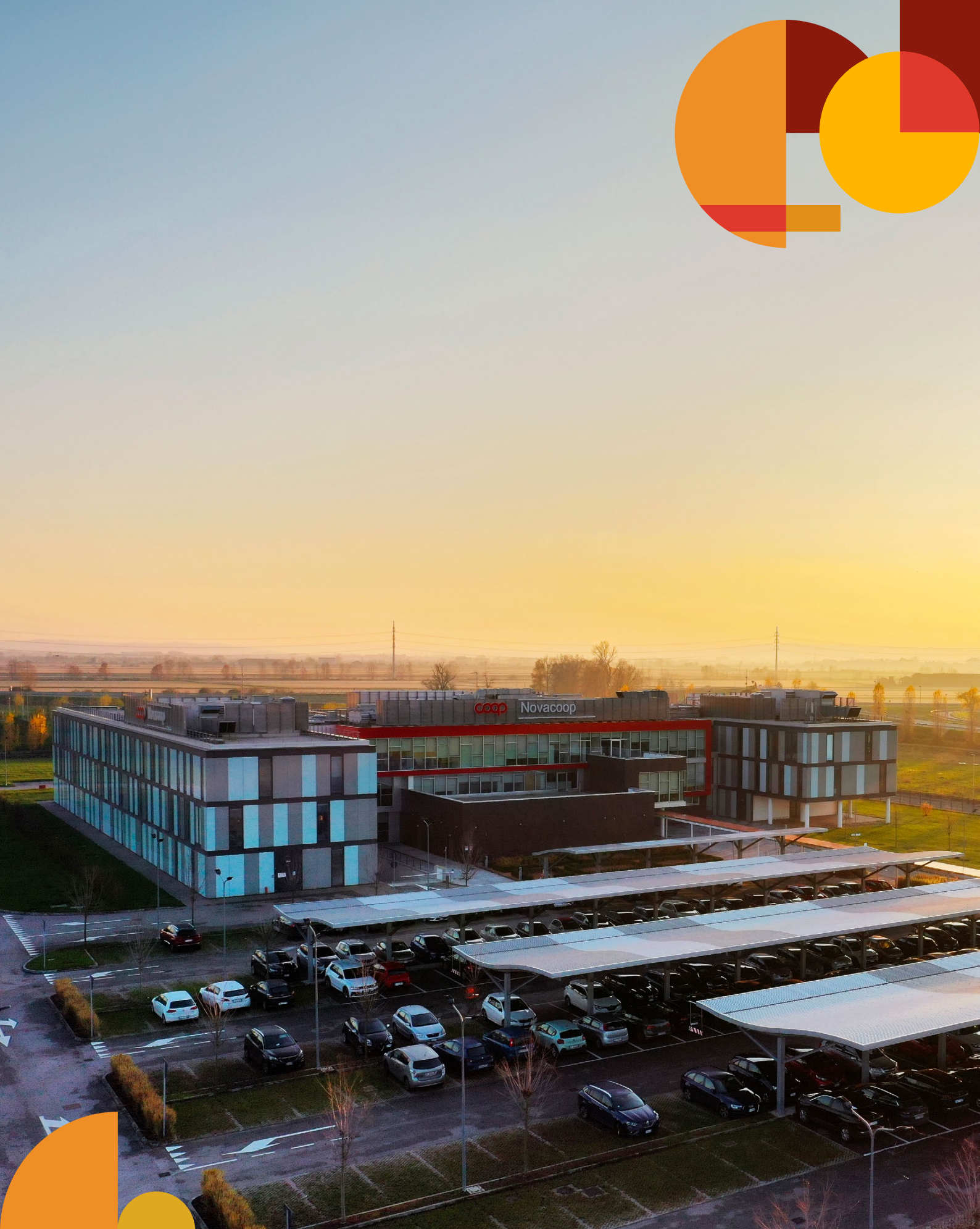
Vista aerea Sede Nova Coop, Vercelli
